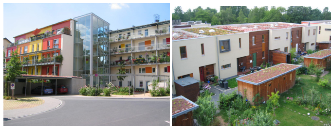
Obr.1 Sdružené objekty jako bytové domy nebo řadová zástavba mají výhodu objemové kompaktnosti a tím i menších tepelných ztrát.
