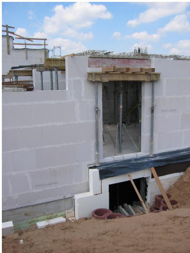
Obr.6 Masivní konstrukce z vápenopískových cihel je pro pasivní domy ideální. Velká objemová hmotnost zabezpečuje vysokou únosnost, výborné akustické vlastnosti a akumulační schopnost při malé tloušťce stěn. Současně se jedná o materiál s velmi nízkou spotřebou primární energie při výrobě. Větší vápenopískové bloky umožňují rychlé mechanizované zdění
