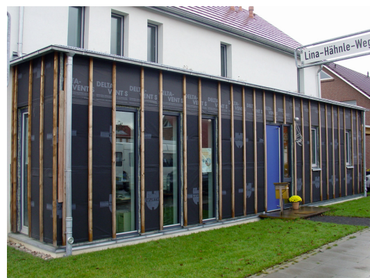
Obr. 2 Příklad provětrávané fasády v novostavbě rodinného domku v Drážďanech ve stavu před namontováním fasádního obkladu. Svislé laťování tvoří vzduchovou mezeru.
