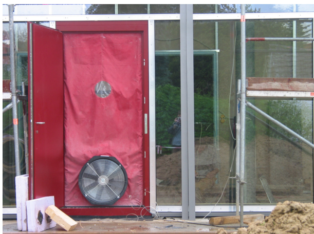
Obr.7 Měření neprůvzdušnosti je nezbytnou součástí realizace a zajištění kvality pasivních domů. Po dokončení vzduchotěsníci vrstvy je nutné provést měření, aby odhalené netěsnosti mohly být včas opraveny.
