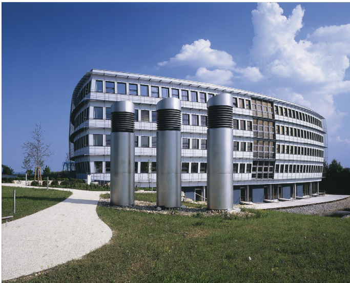
Obr.7 Administrativní budova v Německu, je ukázkou že v pasivních standardech lze stavět i velké objekty na vysoké technické úrovni. Přepracovaný systém topení a chlazení zde využívá pomocí tepelných čerpadel geotermální energii z vrtů. Teplonosná látka proudí betonovými nosníky, které slouží jako akumulátory tepla nebo chladu, s jejich postupným a rovnoměrným výdajem.
