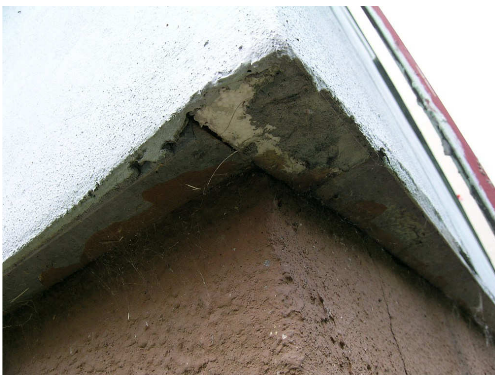
Chybná úprava soklu – chybí soklová lišta
