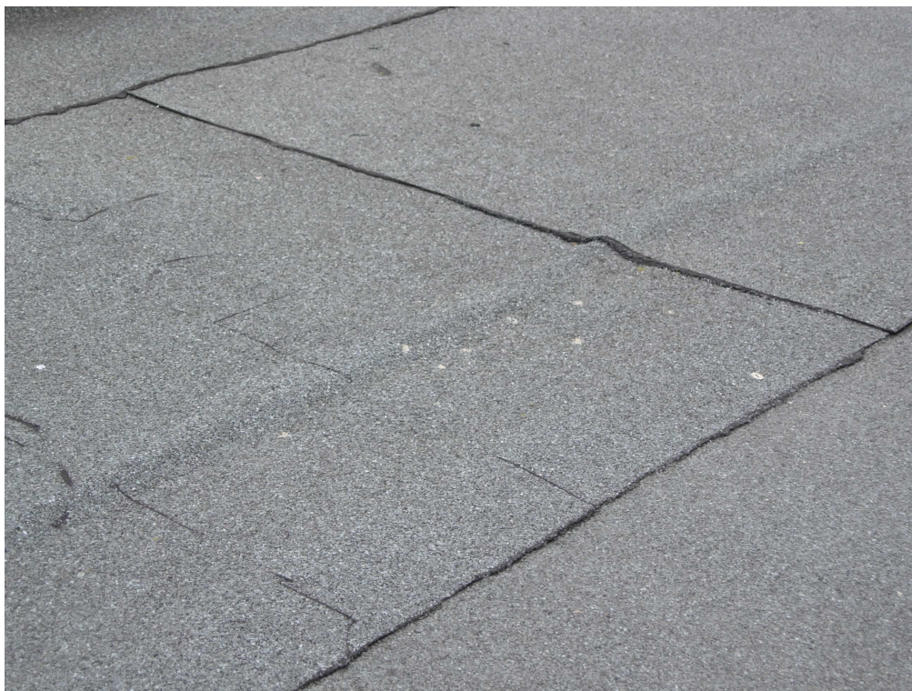
Zvlněná lepenka nad místem spojů tepelné izolace
