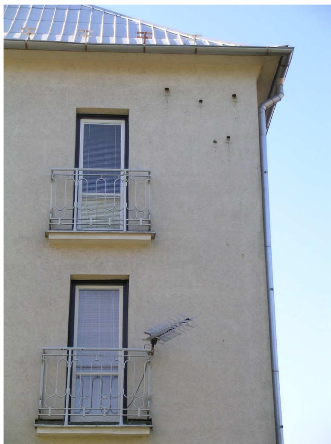
Poškození dodatečné tepelné izolace ptáky
