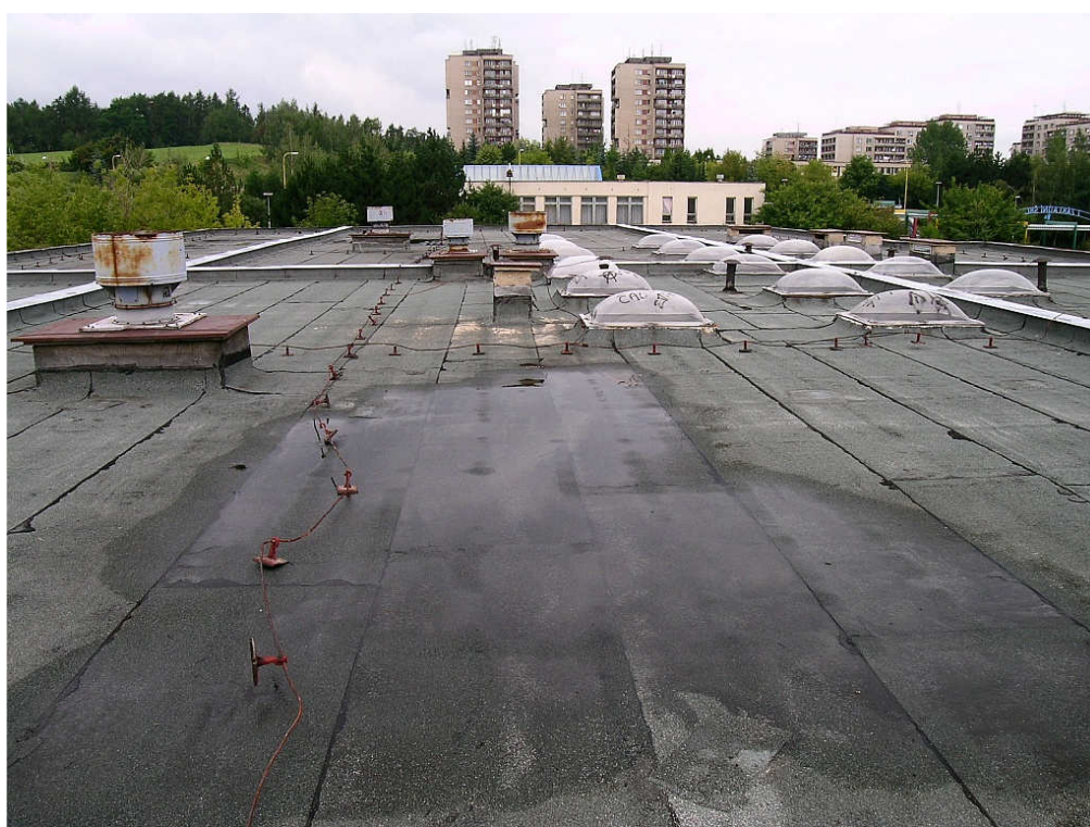
Vyspádování hydroizolace způsobuje vznik louží
