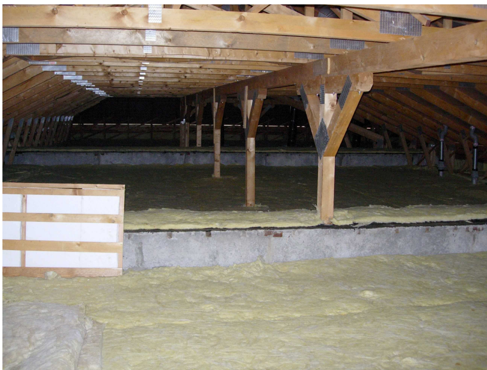
Nezaizolované boční strany nosných stropních prvků
