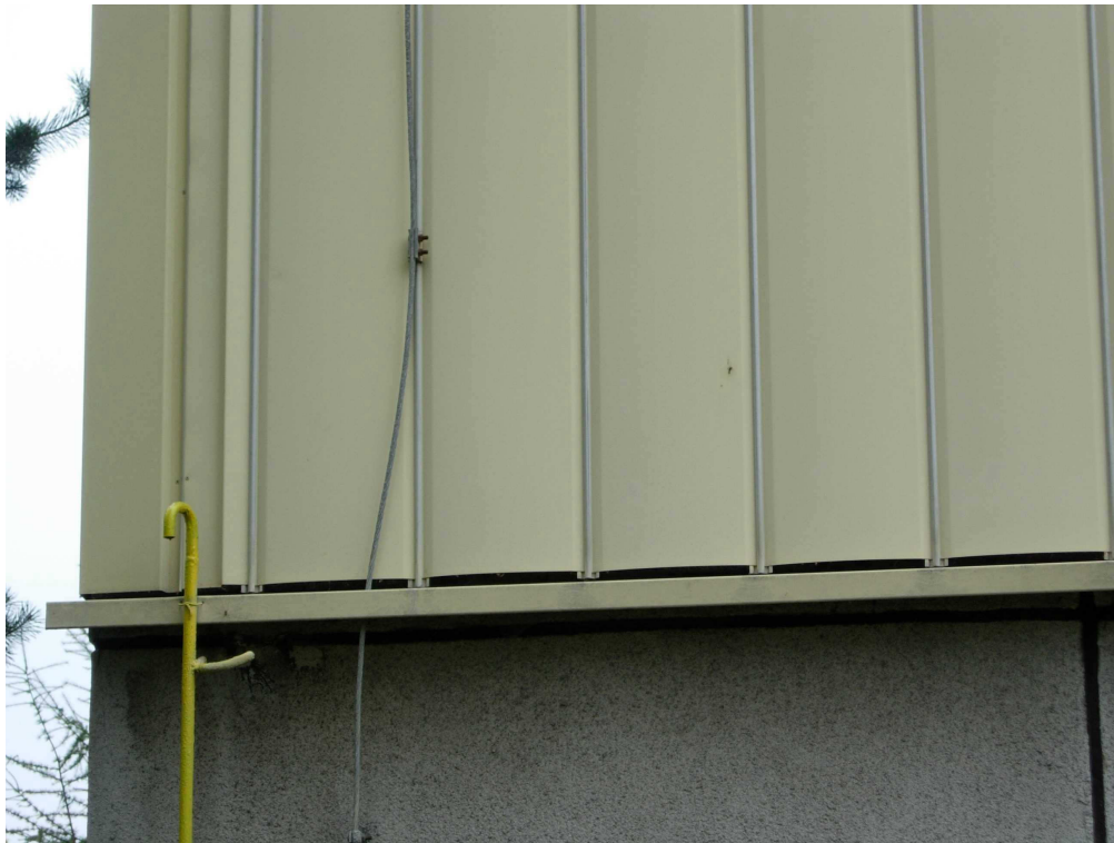
Detail napojení obkladových lamel na soklovou lištu ve štítu
