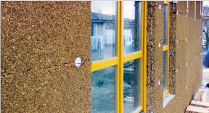
Obrázek 7 | Tepelně izolační korkové desky. Zdroj: Korek Jelínek, spol. s r.o.
