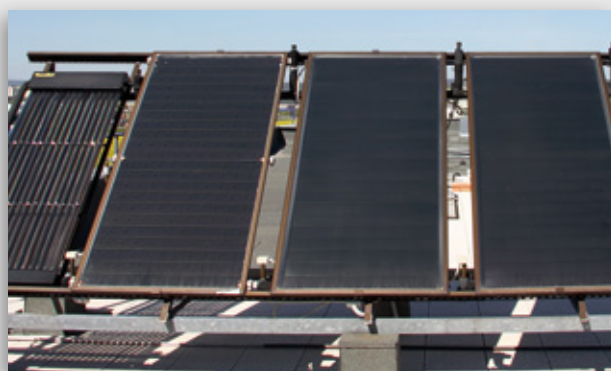
Obrázek 50 | Solární kolektory umístěné na budově FEL ZČU v Plzni
