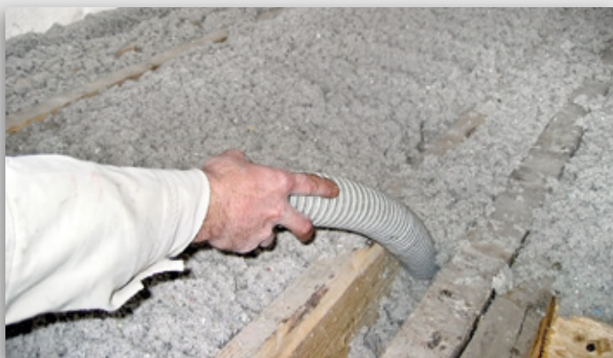
Obrázek 3 | Příklad aplikace celulókové drtě foukáním. Zdroj: CIUR a.s.
