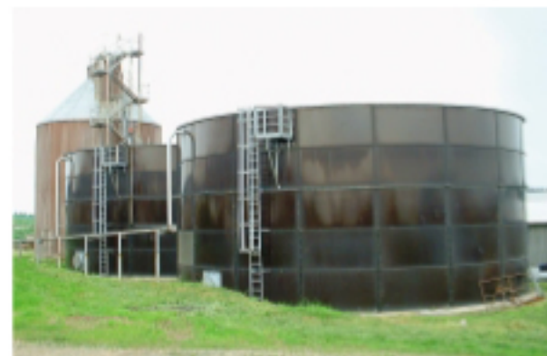
Kontinuální systém na zpracování kejdy. Foto: EkoWATT
