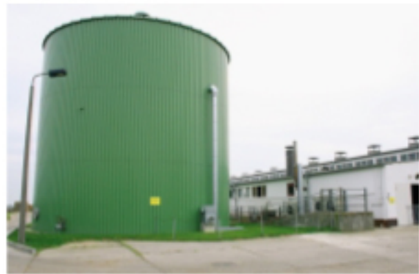
Bioplynová stanice jako součást kravína. Foto: EkoWATT
