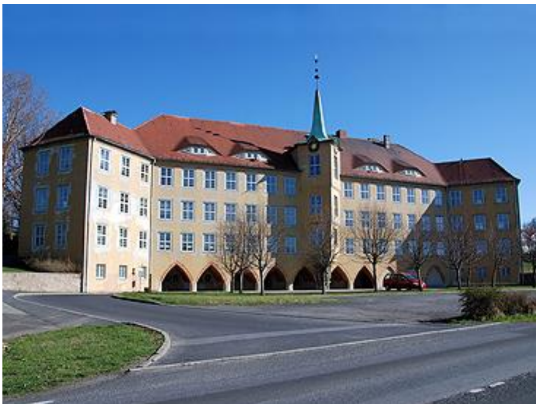
Obrázek 4.19 Škola v Olbesdorfu před rekonstrukcí
