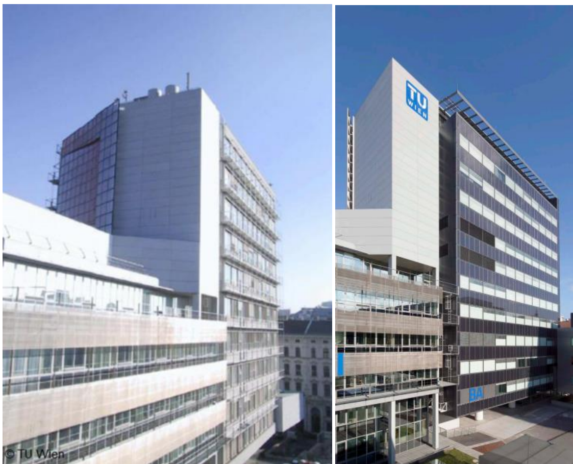
Obrázek 4.22 Plusová energetická budova TU ve Vídni před a po rekonstrukci
