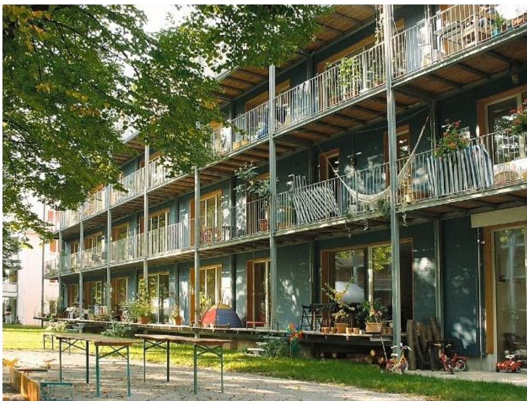
Obrázek 4.4 Jižní strana pasivního bytového domu v létě
