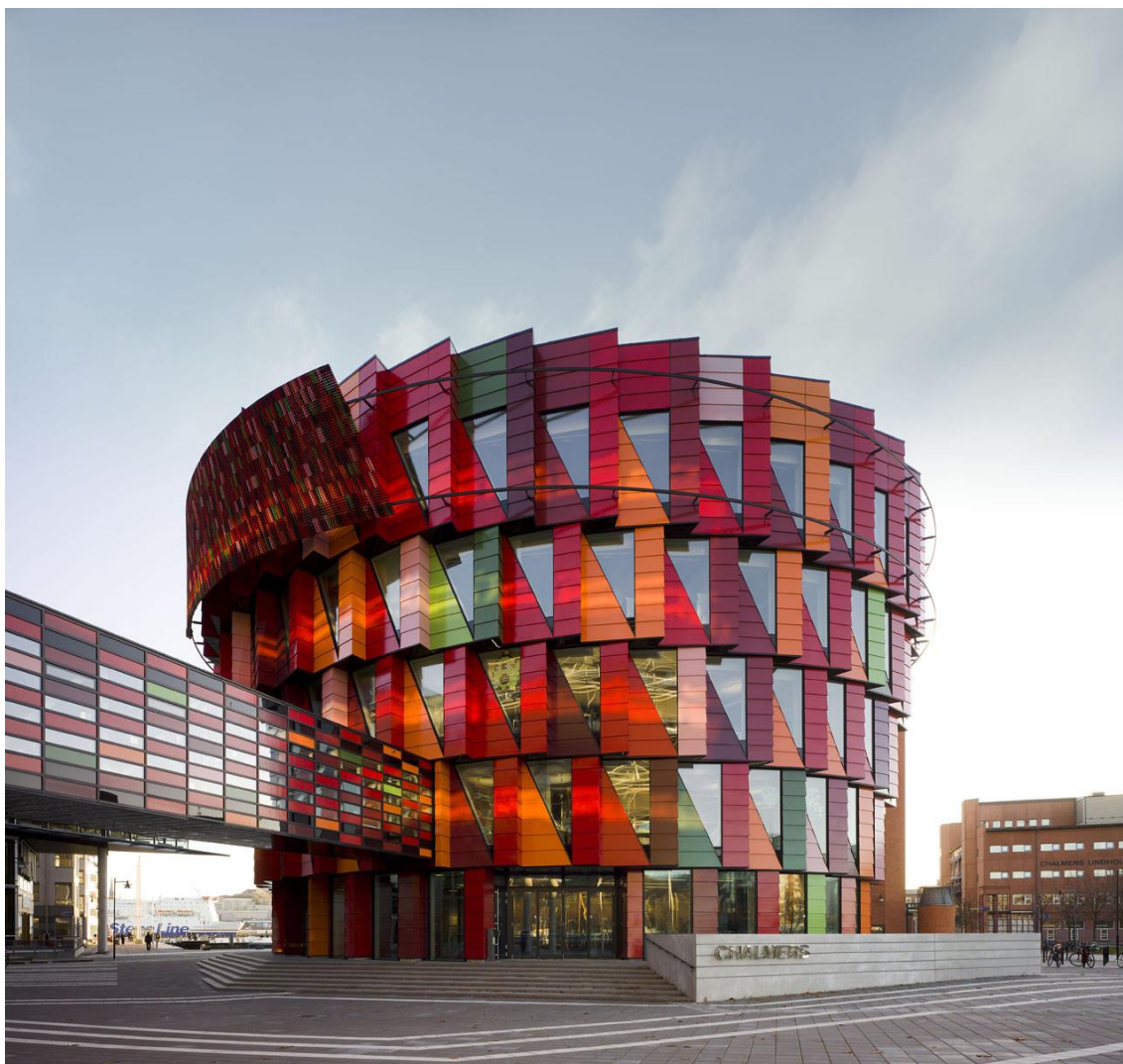
Obrázek 4.17 Administrativní budova Kuggen
