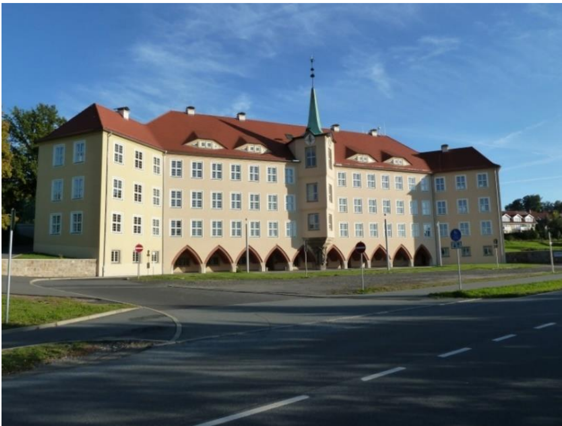
Obrázek 4.20 Škola v Olbesdorfu po rekonstrukci
