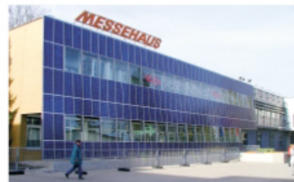
Fasáda z fotovoltaických panelů. Foto: EkoWATT
