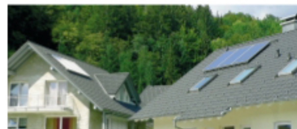
Poloha domu někdy neumožní optimální orientaci solárního systému. Foto: EkoWATT
