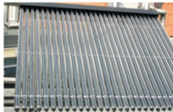
Kolektor z vakuových trubic. Foto: EkoWATT
