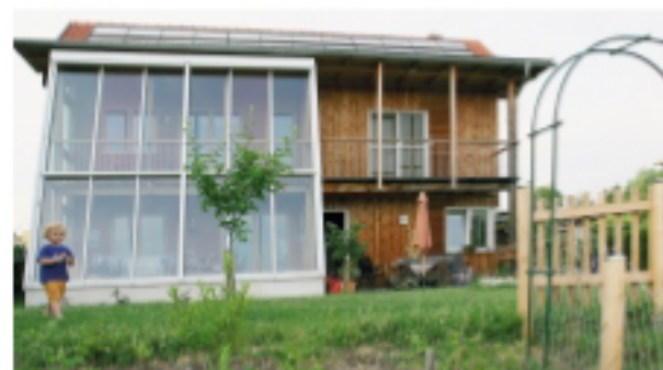
Dodatečně přistavěná nevytápěná zimní zahrada zvětší prostor domu a může snížit jeho spotřebu tepla. Foto: EkoWATT
