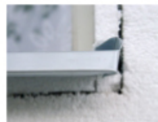
U oken je nutno izolovat ostění, nadpraží i parapety. Foto: EkoWATT
