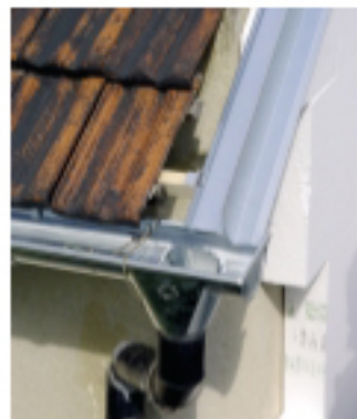
Do nákladů na zateplení je nutno započítat i nově filmsy, parapety a další stavební úpravy. Foto: EkoWATT
