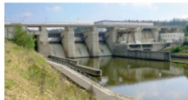
Malá vodní elektrárna Hněvkovice s výkonem 9,6 MW. Foto: EkoWATT
